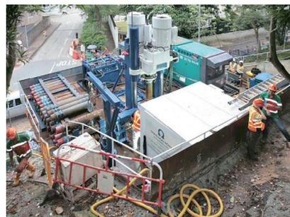
写真-3 レイズボーリング施工状況
