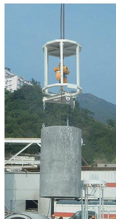
写真-7 PC管吊込み
