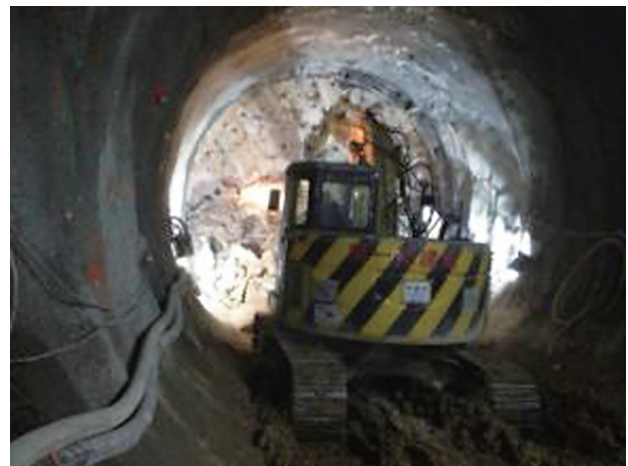
写真-5 油圧ブレーカーによる掘削
