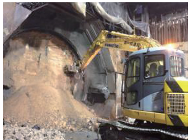
写真－4 ツインヘッダーによる掘削
