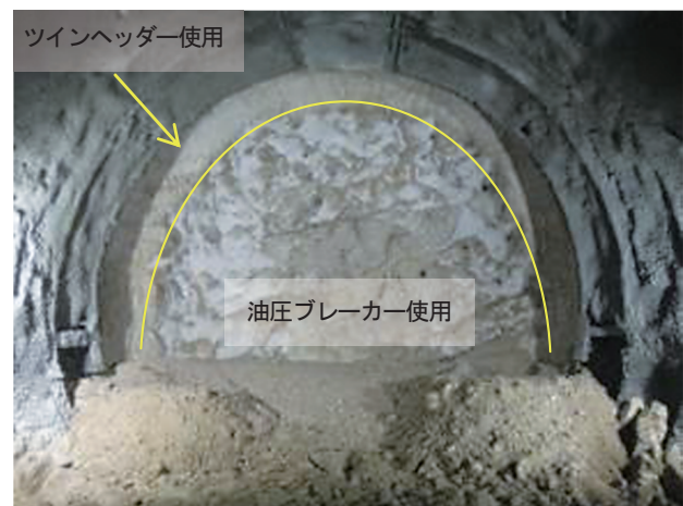
写真-6 切羽状況
