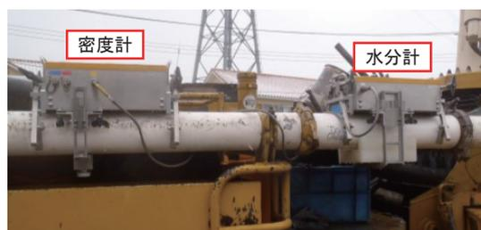
写真-9 連続式RIコンクリート水分計による単位水量測定管理
