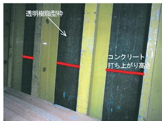
写真-10 透明樹脂型枠による襖部コンクリートの充てん確認状況
