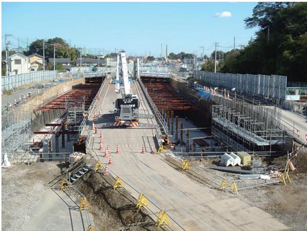
写真一 工事全景 (仮栈橋, 土留工)
