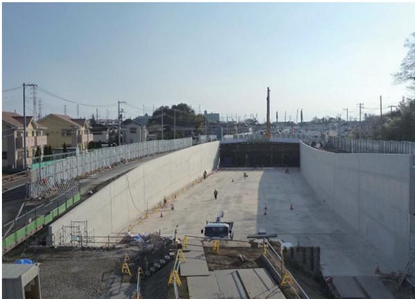
写真二 工事全景 (U型擁壁構築完了)
