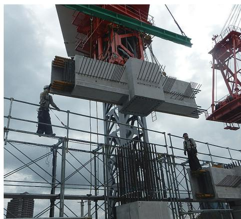
写真一1 柱梁接合部施工状況
