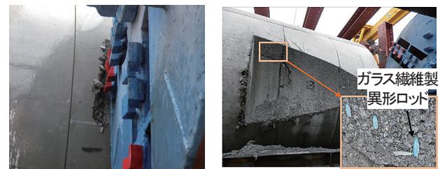
写真一4 切削時および切削面状況 (No.3)
