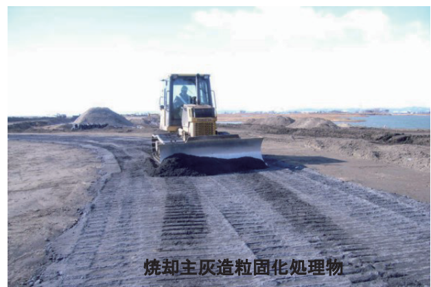
写真一3 現場施工状況
