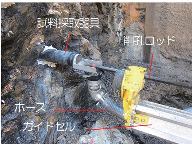
写真三 試料採取器具の設置状況
