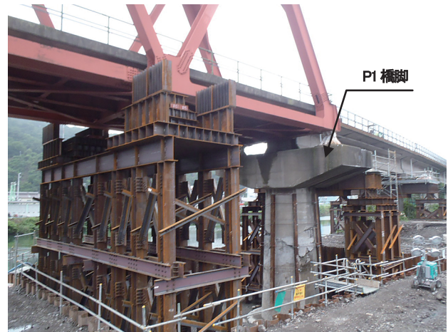
写真-2 仮受架台（P1 橋脚）
