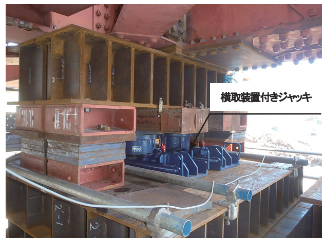
写真-3 横取装置付きジャッキ設置状況
