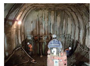
写真一2 掘削状況
