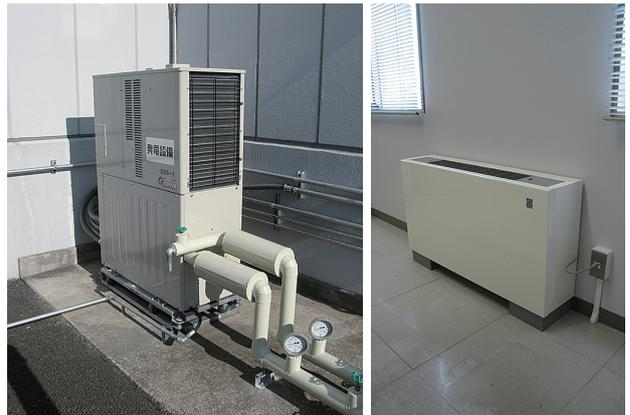
写真一3 コージェネレーション設備・暖房設備
