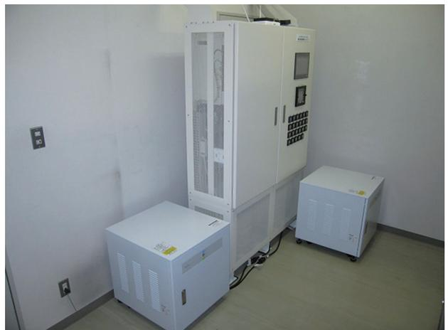
写真一4 電力供給制御コントローラ・蓄電池
