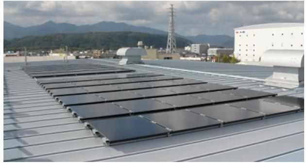
写真一 太陽光発電設備（実験棟）
