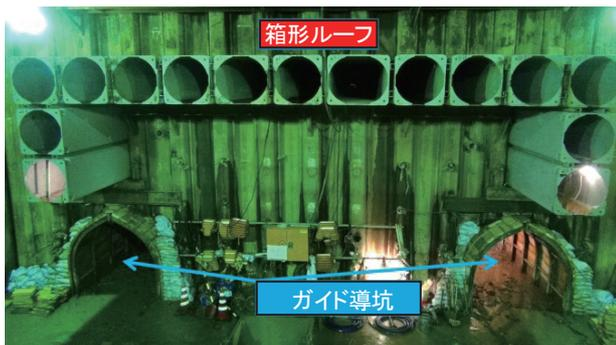
図一2 R&C 工法施工状況
