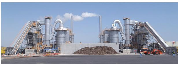
図一 2 焼却処理施設（ストーカー方式）
