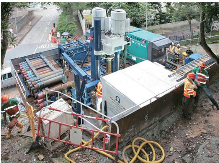
写真-1 レイズボーリング機械設置状況
