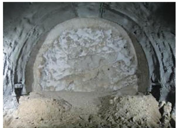
写真二 凍結横坑切羽状況
