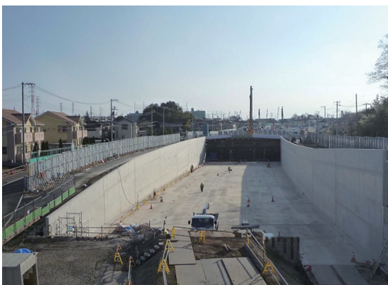
図一 1 工事全景（U型擁壁構築完了）
