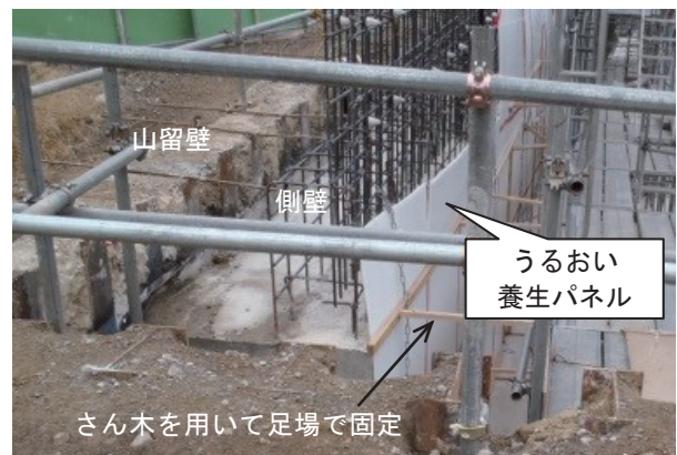
図一 2 うるおい養生パネルの使用状況
