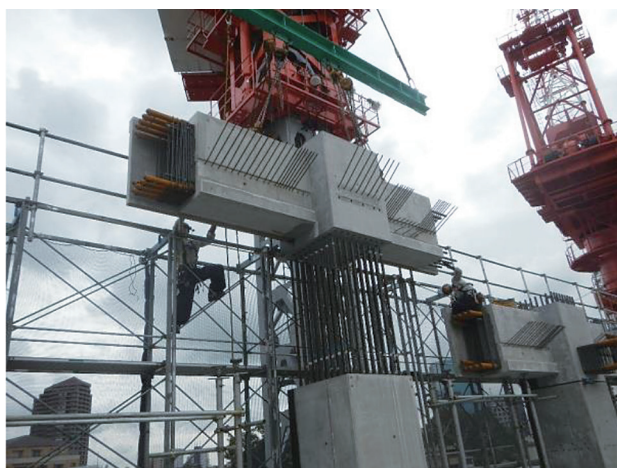
写真一 柱梁接合部施工状況
