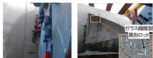
写真二 切削時および切削面状況
