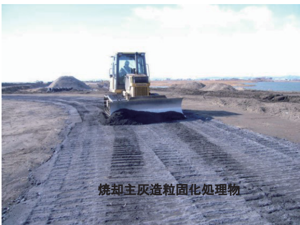
写真二 造粒固化処理物を用いた現場施工
