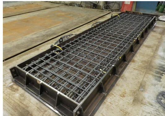
写真一1 合成セグメント（コンクリート打設前）
