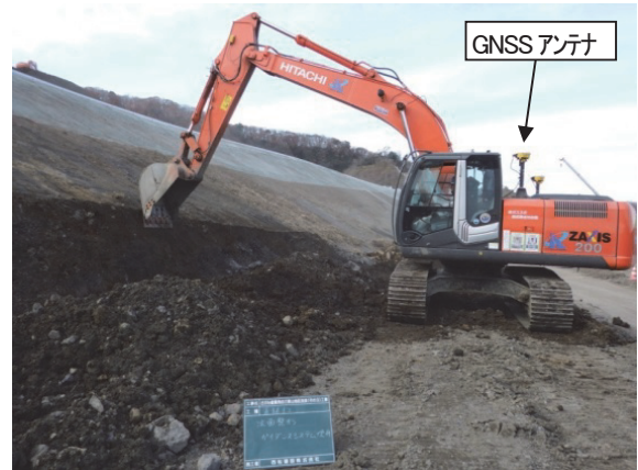
写真-2 バックホウ搭載型マシンガイダンス外観
