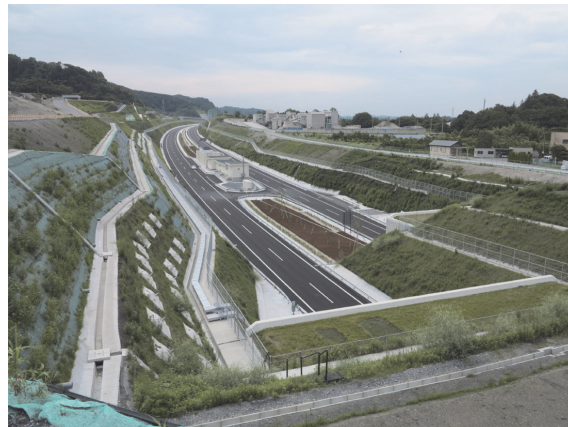
写真-9 完成状況（起点側）
