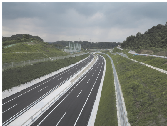
写真-10 完成状況（終点側）
