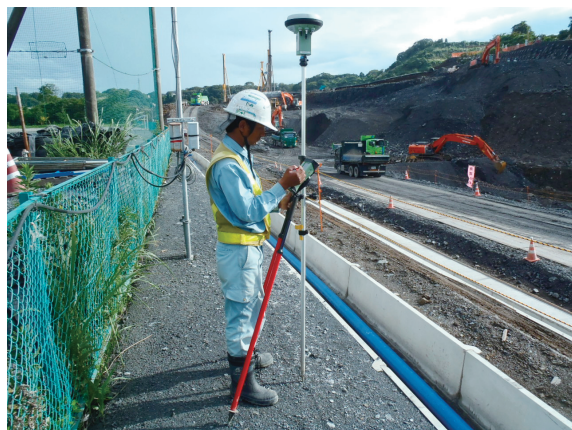
写真-5 ロードランナー使用状況
