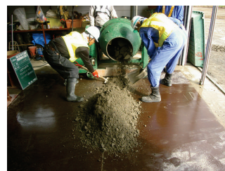
写真-3 ポットミキサ混合状況
