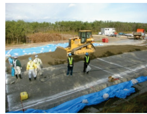
写真-5 CSG 敷均し状況
