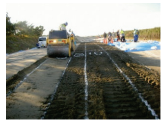
写真-6 CSG 転圧状況
