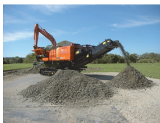
写真-2 移動式破碎機による破碎試験
