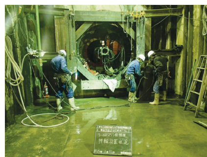
写真-5 仮推進後段取り替え状況
