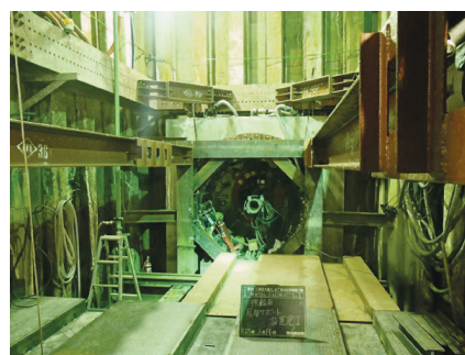
写真-6 仮推進段取り替え完了
