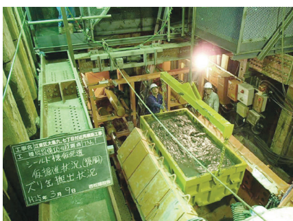
写真-4 仮推進状況
