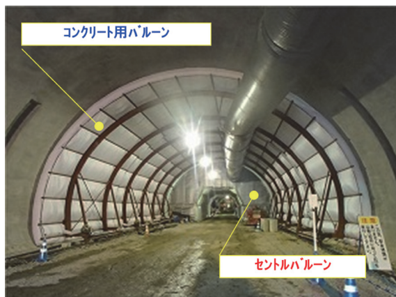
写真-4 バルーン養生状況
