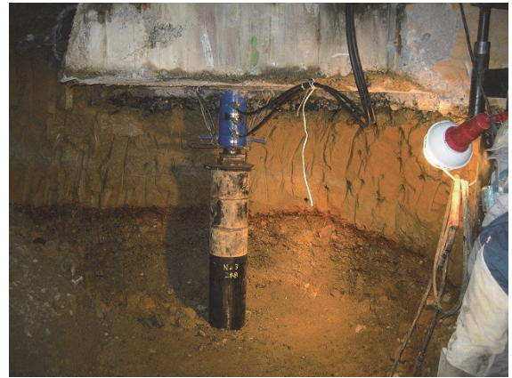
写真-2 鋼管圧入状況
