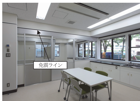
写真-7 間仕切り仕上げ状況
