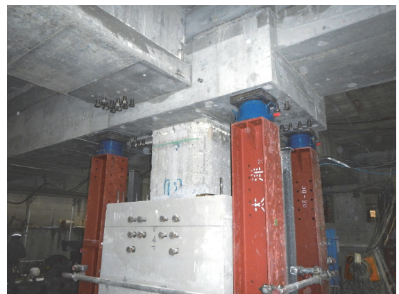
写真-4 サポートジャッキ設置状況
