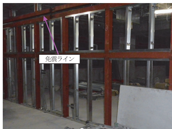
写真-6 間仕切り鉄骨下地状況
