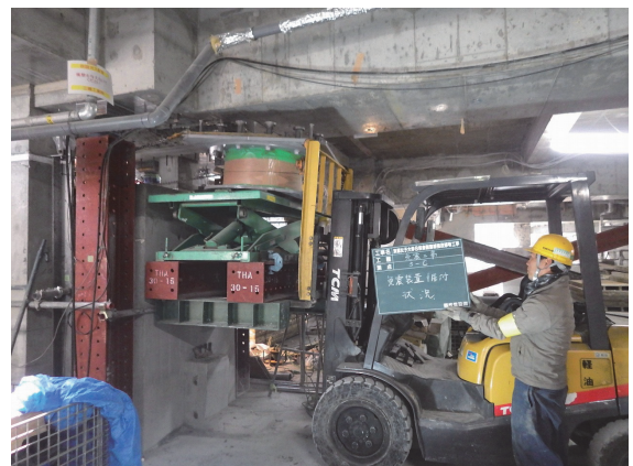
写真-5 免震装置設置状況
