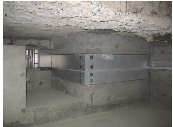
写真-3 基礎下免震施工完了
