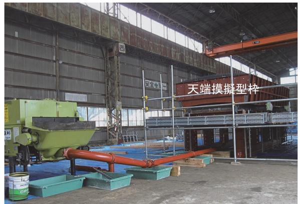
写真－6 天端模擬型枿を用いた施工実験の状況
