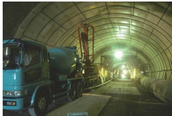
写真-8 覆工コンクリート施工状況
