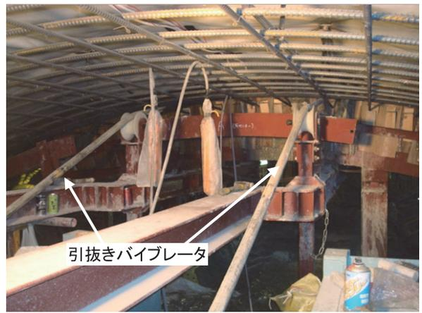
写真－4 引抜きパイプレータの使用状況
