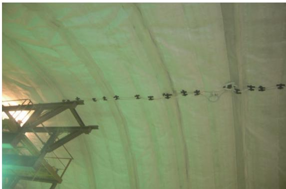
写真-7 吸引チューブおよび充填センサーの設置状況
