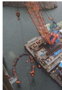
図-4 打設配管
