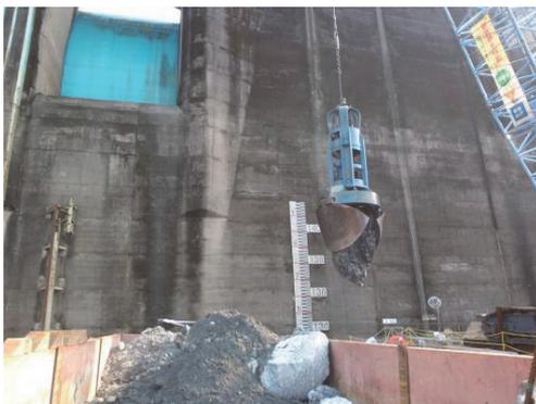
写真-5 既設フーチング撤去状況
