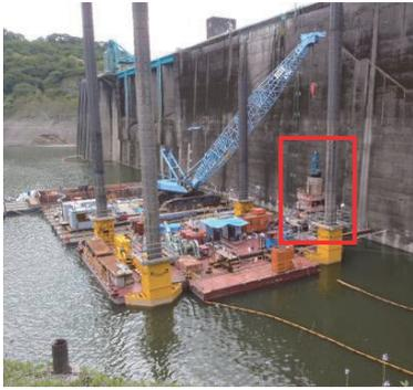
写真-3 SEP 台船による掘削
