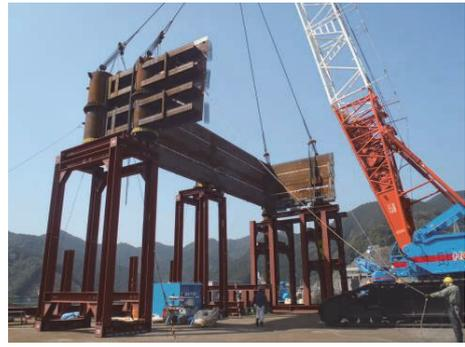
写真-6 大型パネル型枠地組
