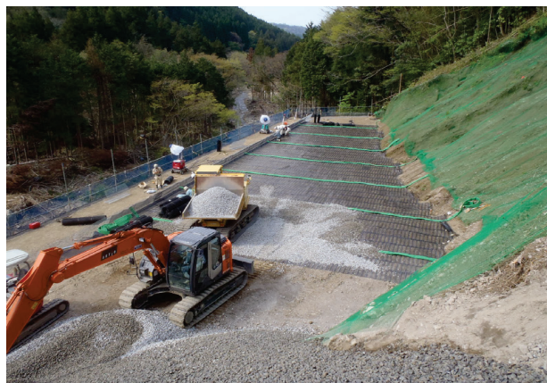
写真－3 法部排水ブランケット層施工状況
