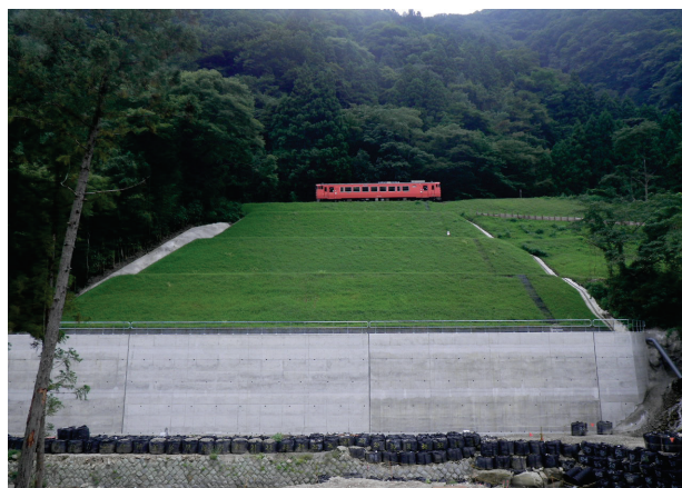
写真－4 完成状況
