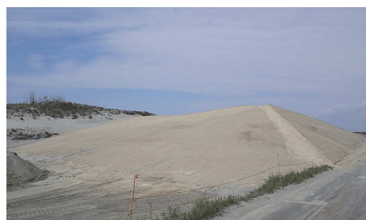
写真-3 CSG 堤築造完了
