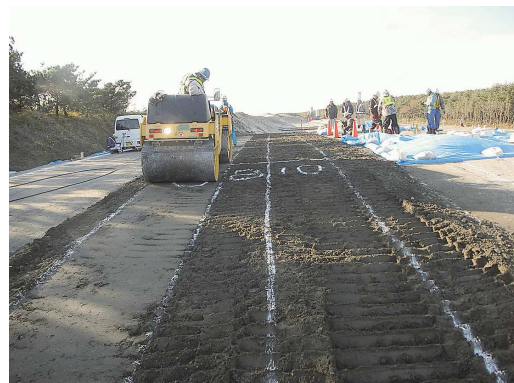
写真-2 試験施工状況
