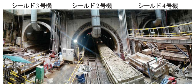
図-2 3台併設シールド掘進
