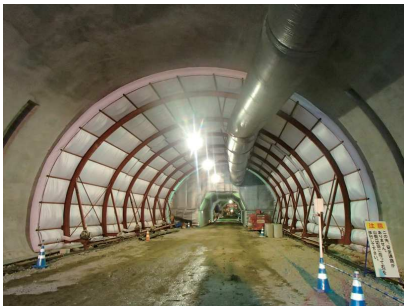
写真-1 施工状況
