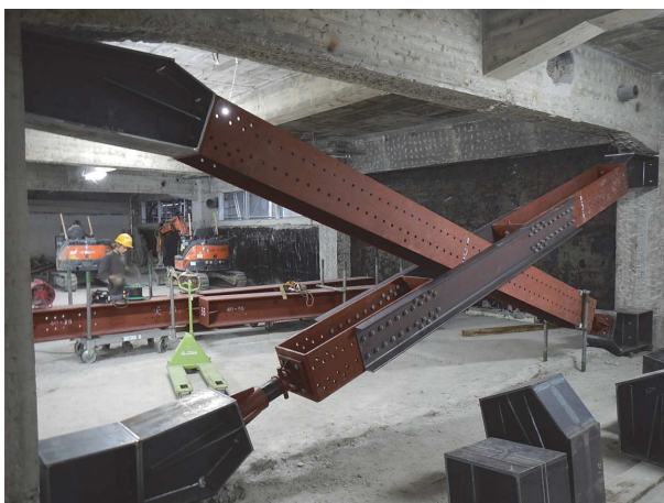
写真-3 仮設ブレース
