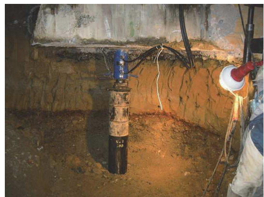
写真-2 鋼管杭圧入状況
