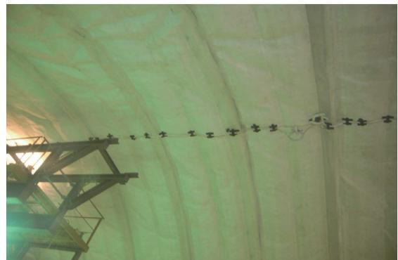
写真-1 天端防水シートへの吸引チューブおよび充填センサーの設置状況固定状況
