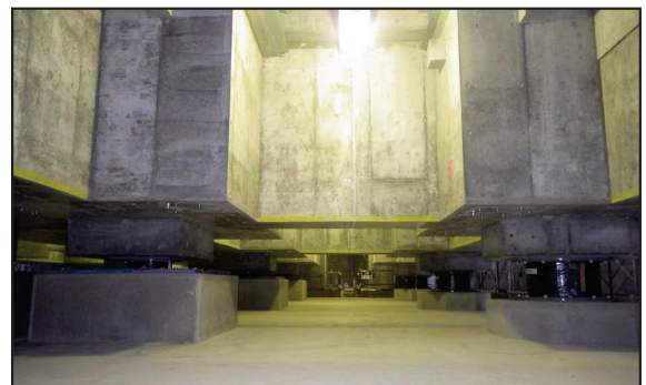
写真-2 免震層全景
