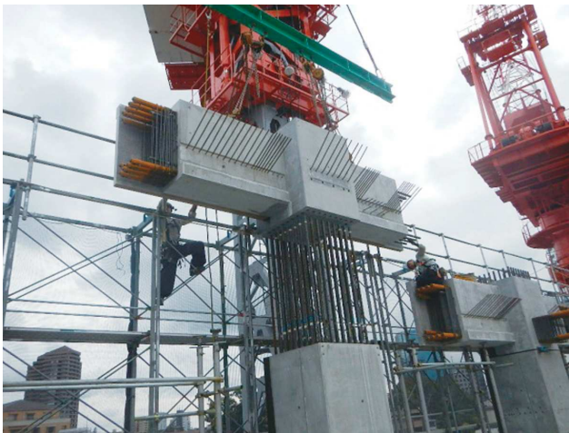
写真-1 柱梁接合部施工状況
