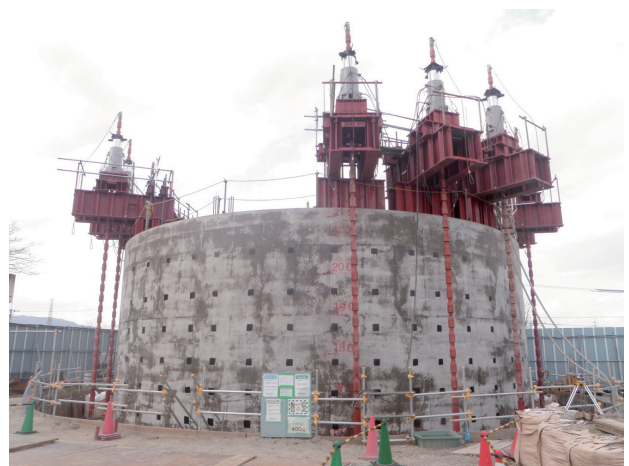
写真－６ 圧入沈設状況
