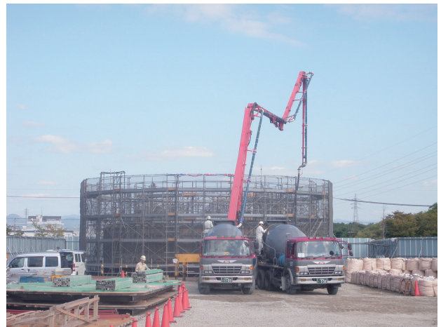
写真－５ コンクリート打設状況
