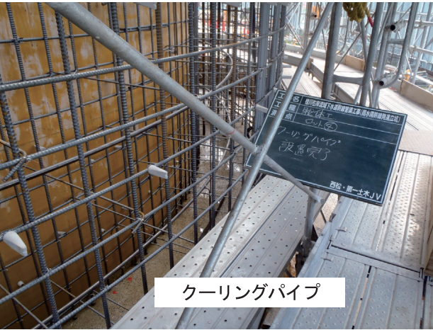
写真-1 クーリングパイプ配置状況（側壁）
