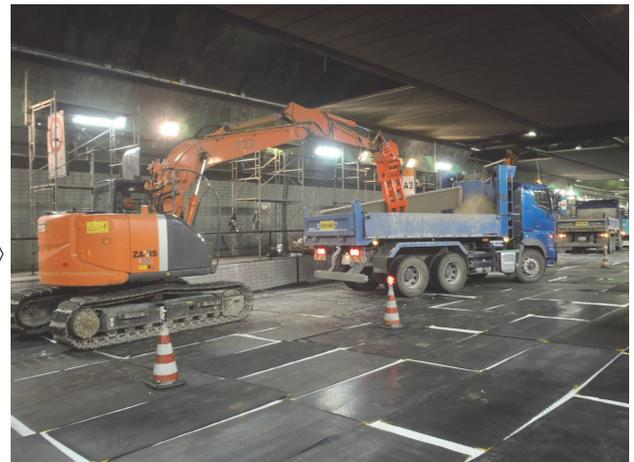
写真-6 換気ダクト板撤去
