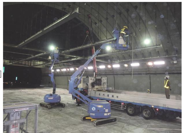
写真-7 吊り金具・受枠撤去設置
