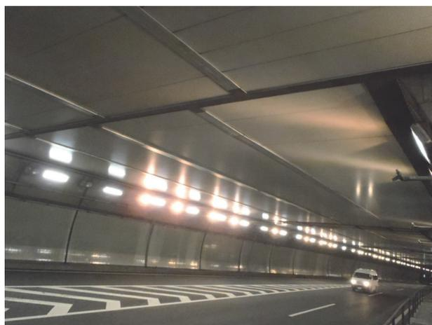
写真-11 換気ダクト板更新後（ダクト外側）
