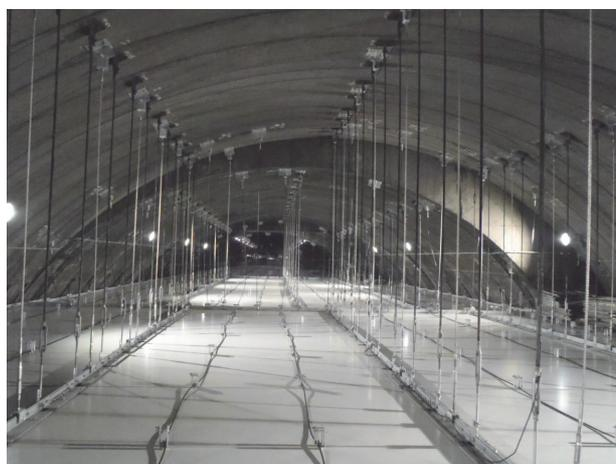
写真-10 換気ダクト板更新後（ダクト内部）
