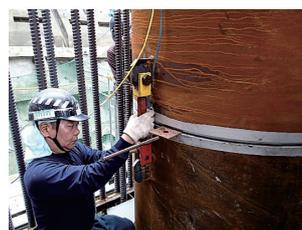
写真-22 鋼管建ち調整 (建止め金具)
