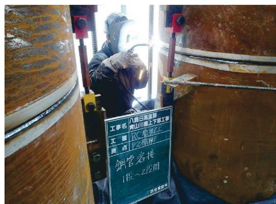
写-26 鋼管溶接 (1層目)
