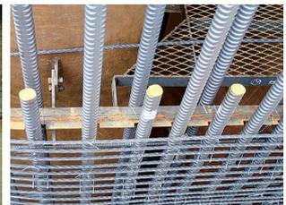
写真-19 鉄筋ゲージプレート
