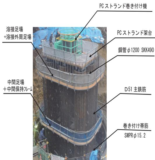
図-5 鋼管コンクリート複合橋脚構成図
