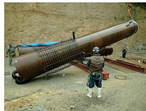
写真-18 鋼管補強リング筋
