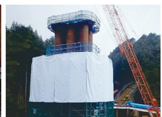
写真-23 鋼管溶接シート養生
