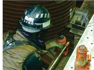
写真-16 鋼管建ち調整 (油圧ジャッキ)
