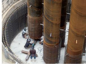
写-3 鋼管補強リング筋組立
