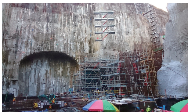
写真-2 明かり躯体部構築状況 左側に西カバーン貫通予定箇所
