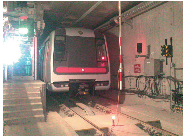
写真一 7 カバーン内プラットフォーム状況
