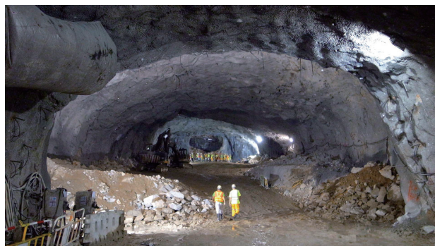
写真-1 上半導坑 掘削・貫通状況
