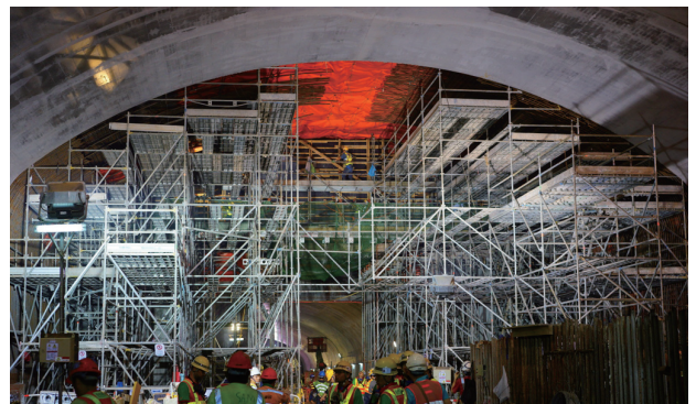
写真-4 追加鉄筋架台
