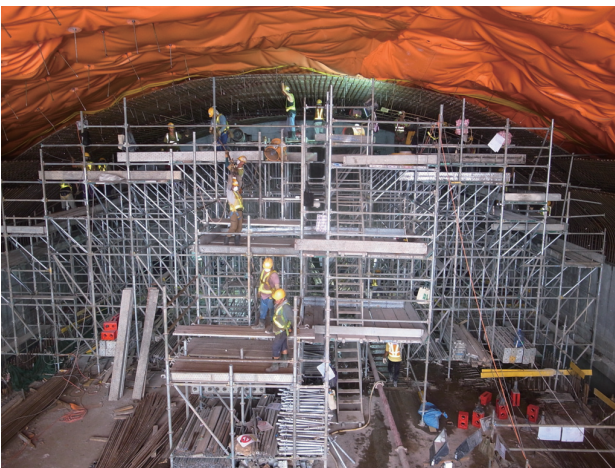
写真―5 支保工兼用鉄筋架台
