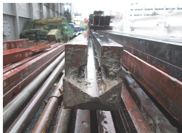
写真-5 C形継手用防護管
