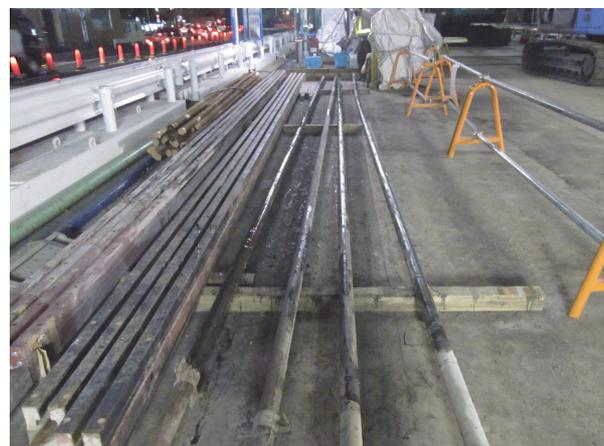
写真-4 C形継手用防護管
