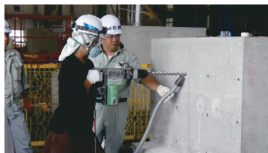
写真－5 ハンマードリルでの削孔状況
