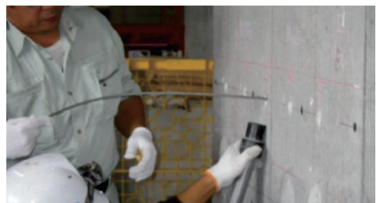
写真－6 孔内清掃状況
