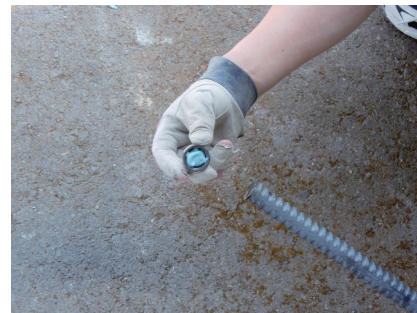
写真－4 特殊ナットの取付け状況
