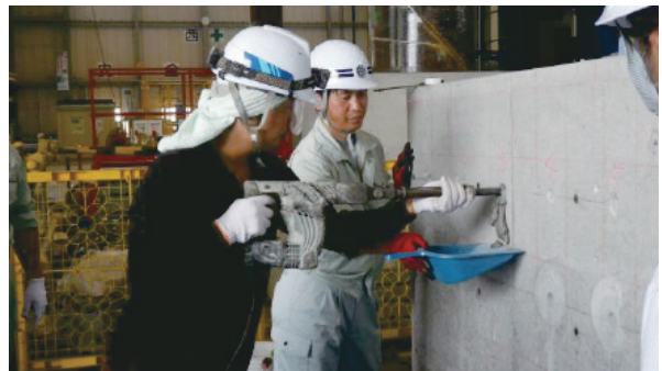
写真－9 「SNB」の打込み
