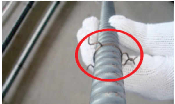
写真－8 上向き施工時の「SNB」落下防止金具
