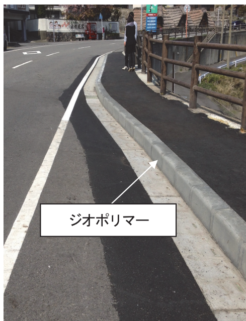
写真-4 施工後の状況
