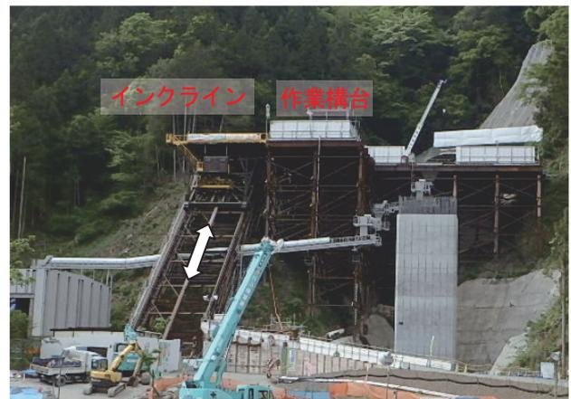
写真-2 インクライン設置完了全景
