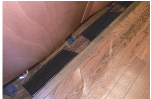
写真-1 客席下吹出口取付状況
