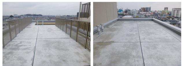
写真-6 防水押えコンクリート仕上状況
