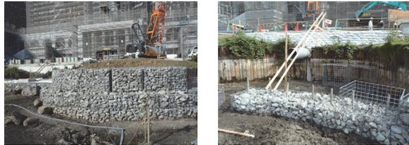
写真-3 蛇籠施工状況
