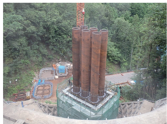
写真-1 鋼管建て込み状況
