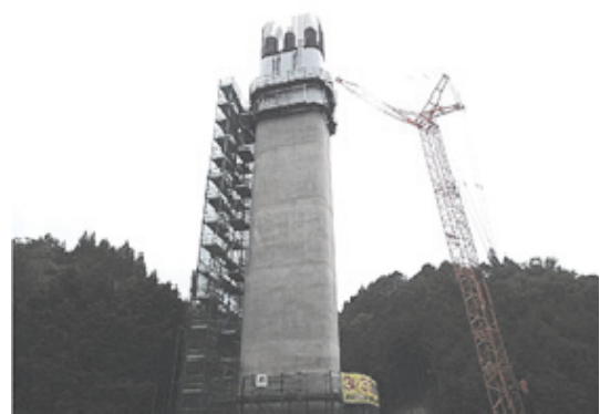
写真-2 P2 橋脚完了
