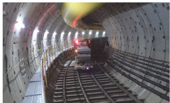
写真-1 完成後トンネル写真
