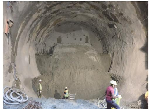
写真-1 SCLトンネル施工状況
