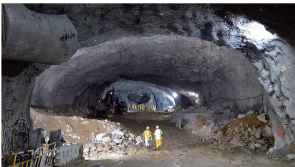
写真－１ カバーン掘削
