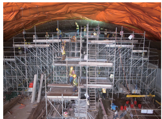
写真－２ 覆工支保工
