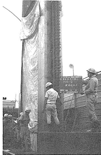
写真-4 橋脚基礎②,③エレメント鉄筋かごの建込み
